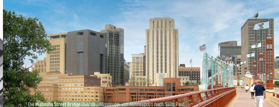
Die Wabasha Street Bridge über den Mississippi von Minneapolis nach Saint Paul
